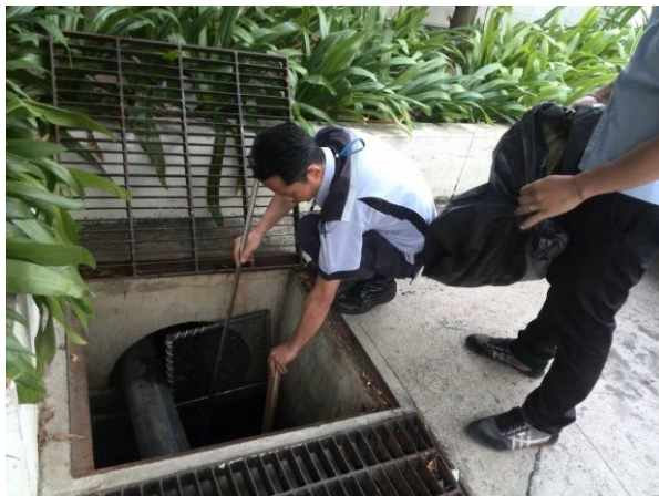
ตะแกรงดักมูลฝอยบริเวณจุดเชื่อมต่อระบบระบายน้ำของเมืองพัทยา และการดักเศษขยะ
