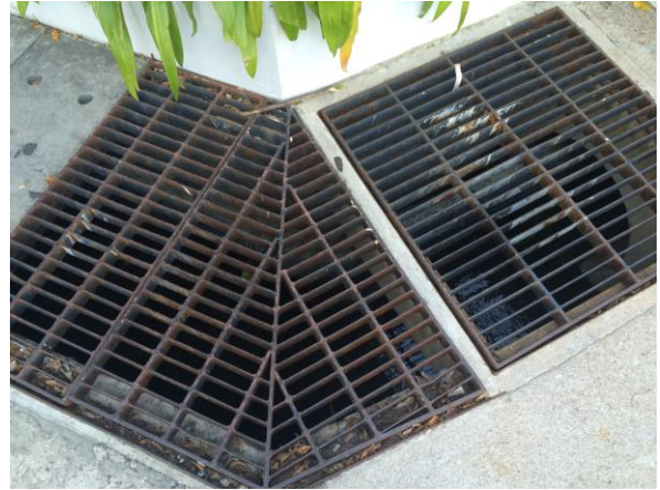
ตะแกรงดักมูลฝอยบริเวณจุดเชื่อมต่อระบบระบายน้ำของเมืองพัทยา และการดักเศษขยะ
