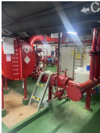
ระบบน้ำสำรอง และ Fire Pump
